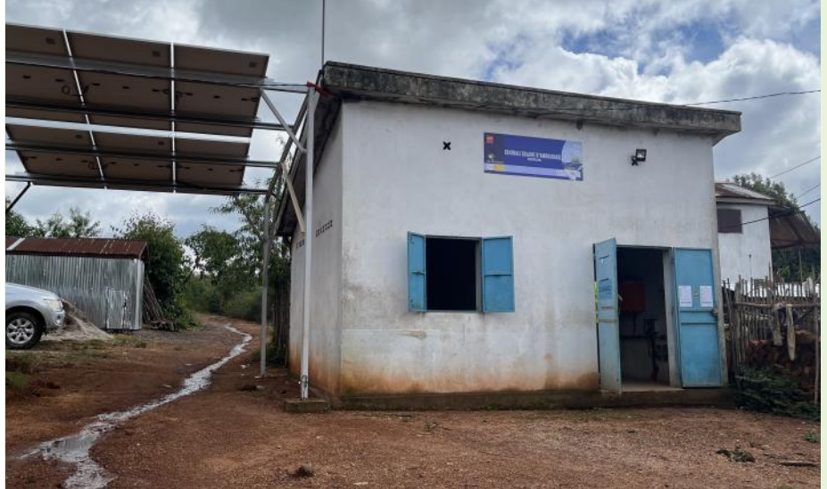
Extension de la centrale photovoltaïque d'Ambatolaona
