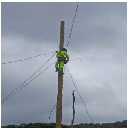
Travaux d'extension et de maintenance du réseau à Tolongoïna
