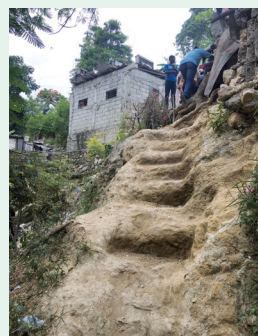
Escalier menant à Canot avant l'aménagement (juin 2017)
