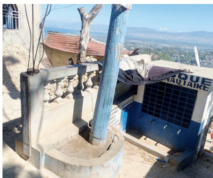
Kiosque d'eau construit par l'OSC GCDN dans le quartier de Sarrazin
