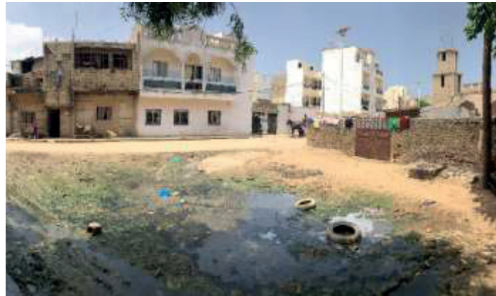
Exemple de point bas imperméabilisé et sur lequel des eaux stagnent (Djaka Ndiador)
