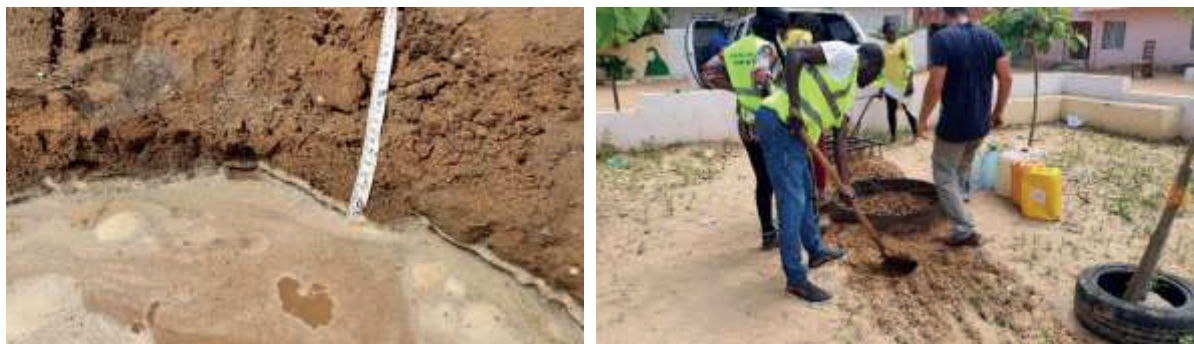
Suivi d'un essai à 20 cm de profondeur (à gauche) et mise en place d'un essai sur sable décompacté (à droite)
