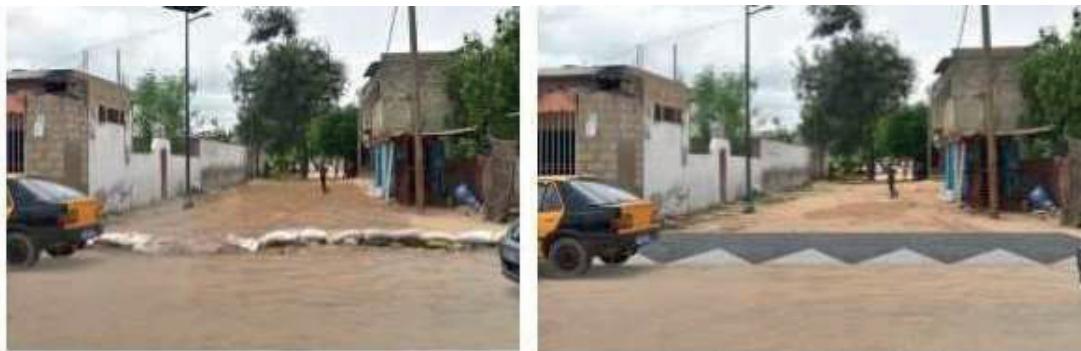
Exemple d'aménagement d'un arrêtoir d'eau (photomontage : GRET)
