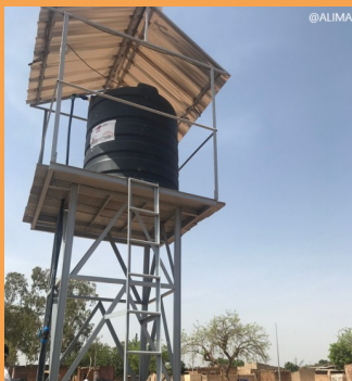
Construction d'un support pour polytank à la maternité de Polesgo (ALIMA)
