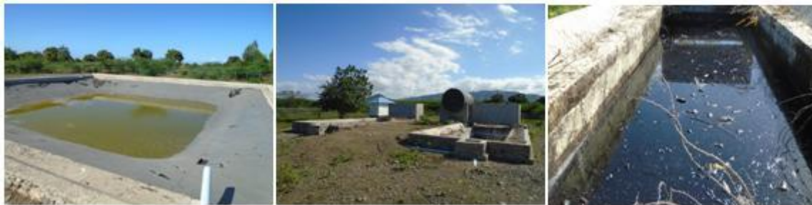
Photo 14 : La station de traitement de Limonade (Cap-Haïtien)
