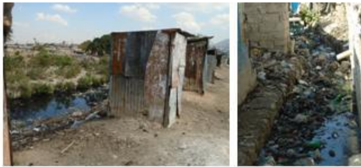
Photo 7 : Toilettes en bord de canaux à Cité l'Eternel
