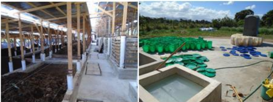
Photo 15 : Station de traitement et de valorisation en compost Soil
