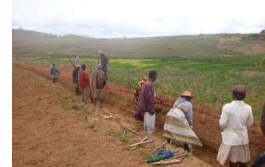
Installation de canaux d'infiltration
