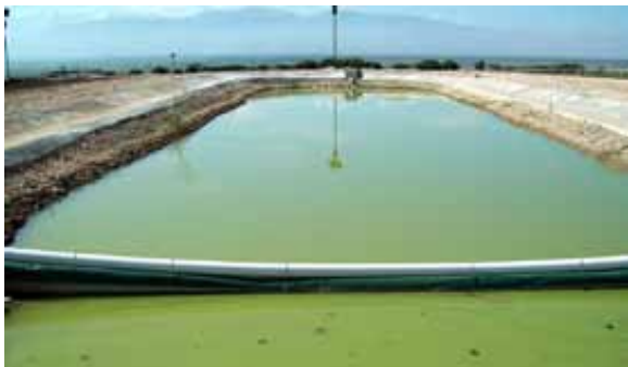
Bassin de lagunage en Haïti.
