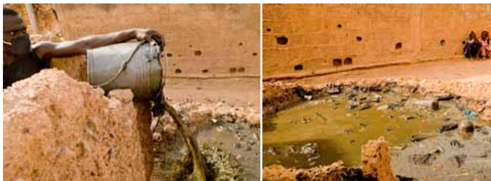
Vidange manuelle à Ouagadougou (Burkina Faso). Les boues sont déposées dans un trou dans la rue.
