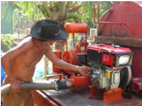
Test d’un système de vidange de fosse à Kampot (Cambodge).
