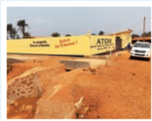
Atom de La Frontière, vue de l'extérieur (2018)
