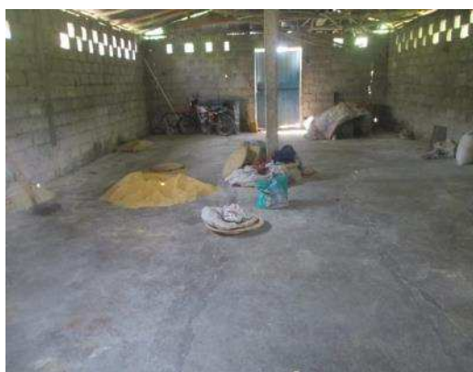
Salle de vannage avant l'ouragan Matthew
