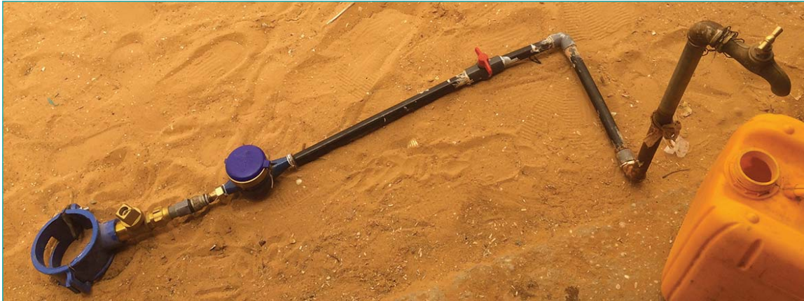
Montage standard d'un branchement
