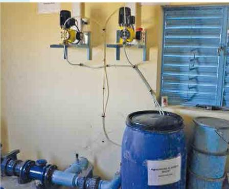
Système d'injection par pompe doseuse électrique
