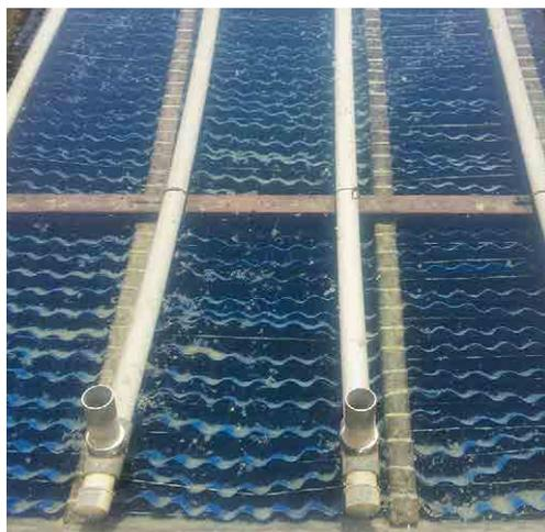
Décanteur lamellaire avec un fond en forme de « V »,
