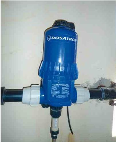
Pompe doseuse hydraulique (type Dosatron)
