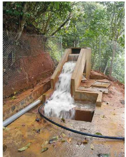
*Cascade d'aération en béton*
