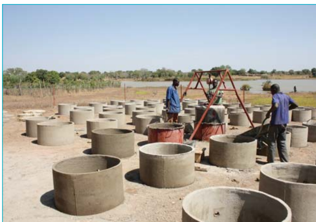
Figure 9 - Site de production de toilettes d'un sanimarché au Burkina Faso
