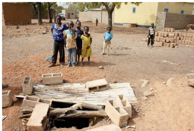
Fosse creusée pour une latrine à Fara, en attente de la pose par le Yilemd-raaga
