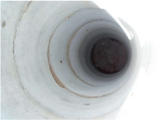
Buses superposées à l'intérieur de la fosse / Latrine Yilemdé
