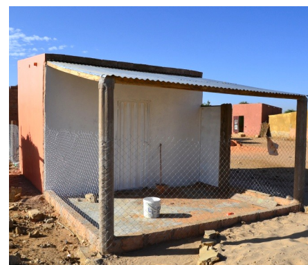
Construction de l'unité artisanale de Keur Madickè
