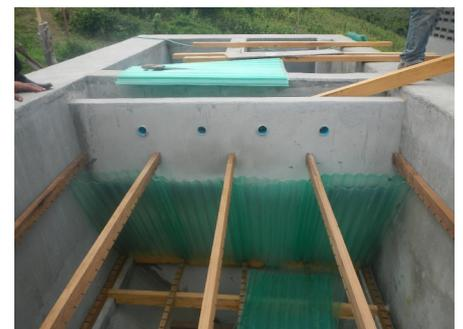
Installation des lamelles du bassin de sédimentation de la station de MeuangPa
