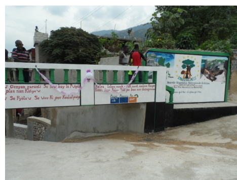
Avant / après des travaux réalisés par Nosca à Petit Descayettes
