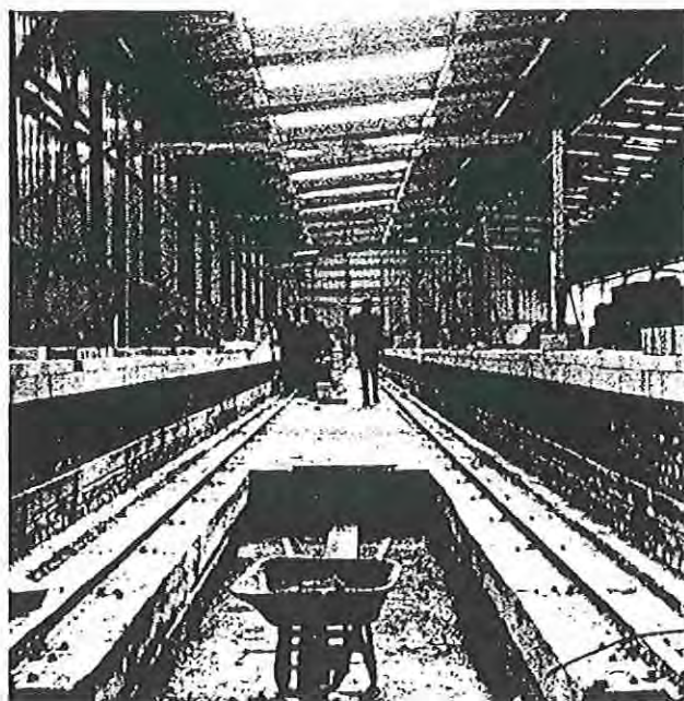
Fig. 25 Début de la construction des piédroits du four
