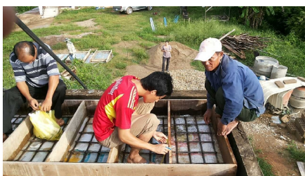
Préparation des dalles de fonds du filtre à sable de la station de Hinheup
