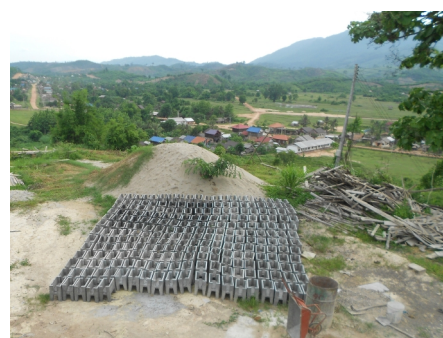
Les boîtes des compteurs d'eau de MeuangPa prêtes à être installées
