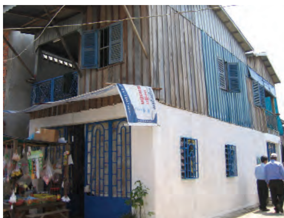
Travaux récents de surélévation à Prek Tanou.
