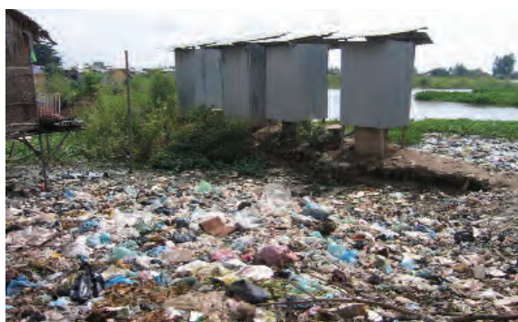
Latrines collectives financées par une ONG, quartier du Bassac.
