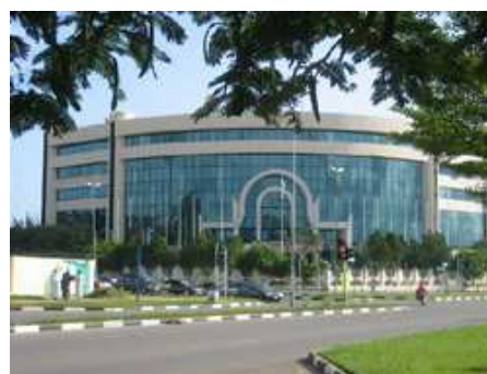
Siège de la CEDEAO à Abuja, Nigeria
