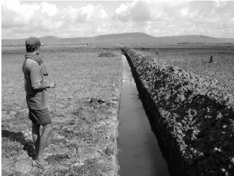
△ Digue en cours de construction à Samrong Leu (polder 4), en mai 2005. La nature des sols impose de réaliser des diguettes volumineuses, ce qui constitue un investissement en temps considérable et une réduction de la surface utile de la parcelle. Le système n'est accepté que si les propriétaires de parcelles limitrophes répartissent entre eux le travail et l'emprise au sol de l'aménagement. Le refus de collaborer d'un seul propriétaire entraîne des abandons en cascade de ses voisins.
