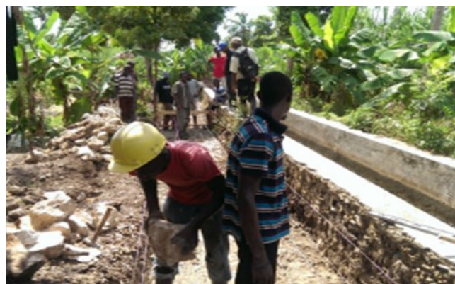
Canal d'irrigation à Baie-de-Hennes
