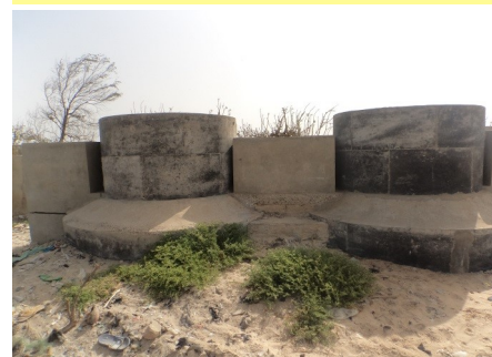
Tests des boues de vidanges
