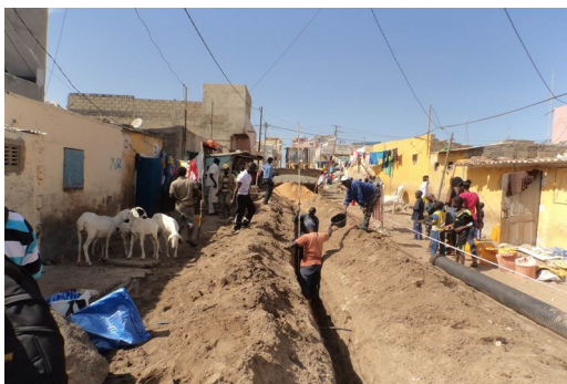
Travaux de pose de conduite dans les ruelles de Guet Ndar
