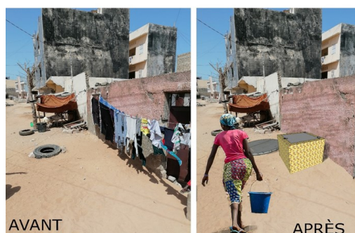
Ouvrage communautaire pilote : puisard
