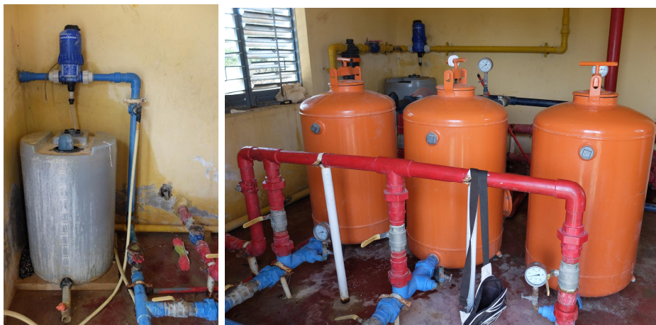
Etat actuel de la station de traitement d'eau potable de Ndialakhar
