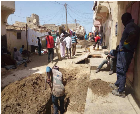
Raccordement au réseau de la tranche conditionnelle
