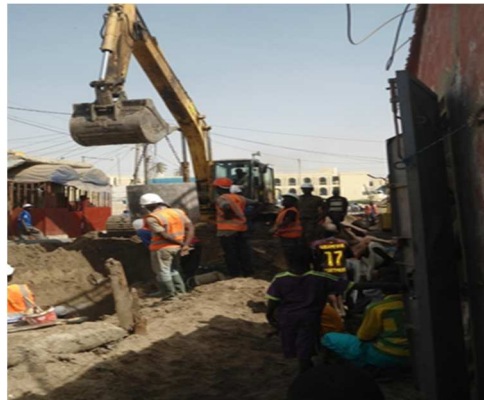
Les engins en action sur les travaux de la tranche conditionnelle
