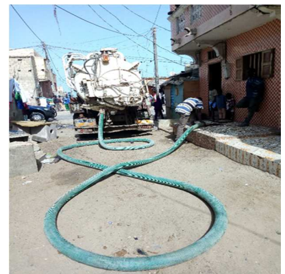
Vidange des fosses septiques et comblement
