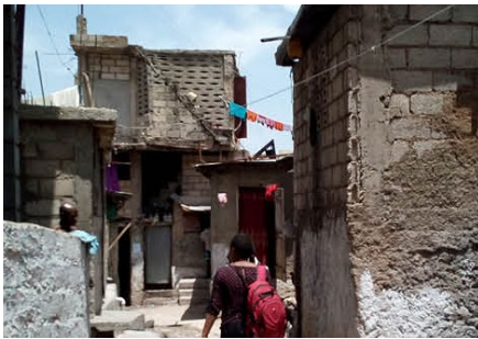
Habitations dans le lit de la ravine
