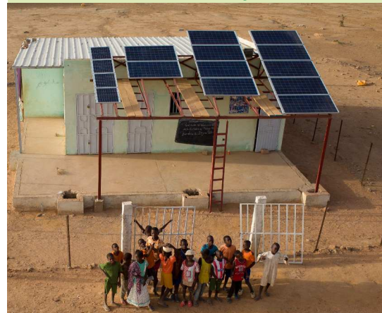
Plateforme du village de Dar el Barka
