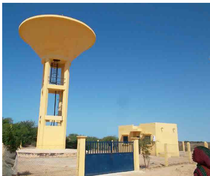
Station de potabilisation de Mboubène
